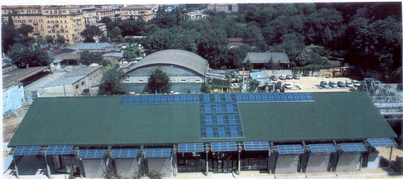
Copertura Museo dei Bambini - Roma - Sistema Coverclima abbinato a pannelli fotovoltaici.
