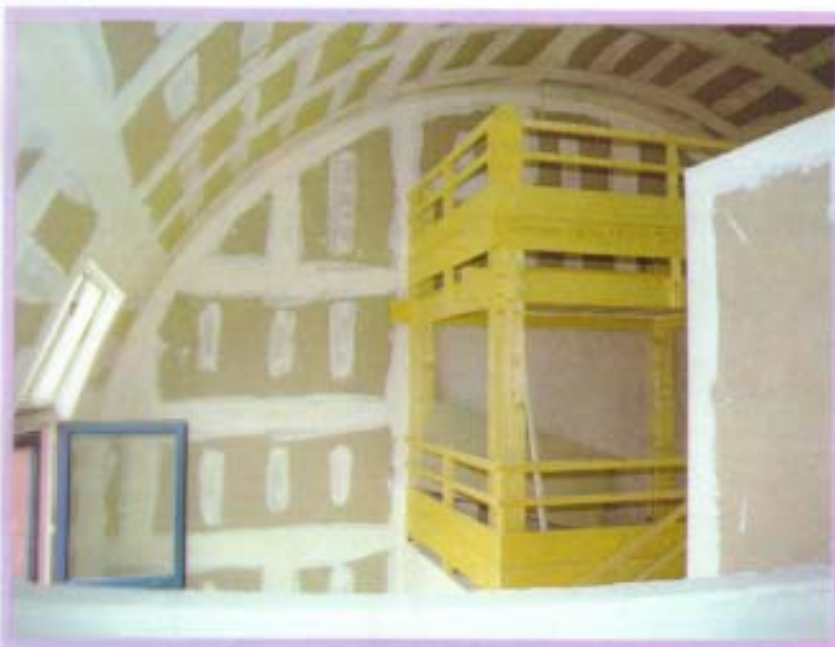
Réalisation de cloisons séparatives Prégymétal de 5 m de hauteur et jonction avec le plâton côté habitant les rampants Givors.
