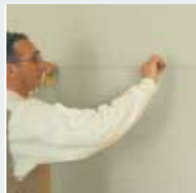
Tracciare le linee sulla parete a distanza compresa tra 600 mm e 750 mm
