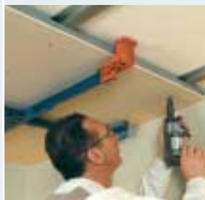
Fissare i pannelli IMMOTUS R+ ai profili ogni 300 mm utilizzando viti per cartongesso da 42mm
