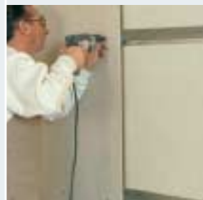
Fissare i pannelli IMMOTUS R+ ai profili ogni 300 mm utilizzando viti per cartongesso da 42mm
