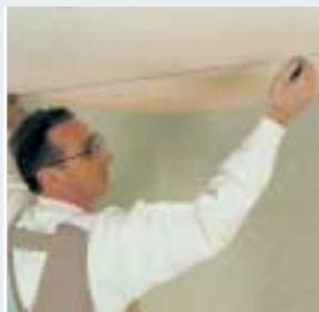
Tracciare le linee sul soffitto a 600 mm di distanza
