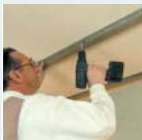
Fissare i profili metallici per IMMOTUS R+ sulle linee tracciate
