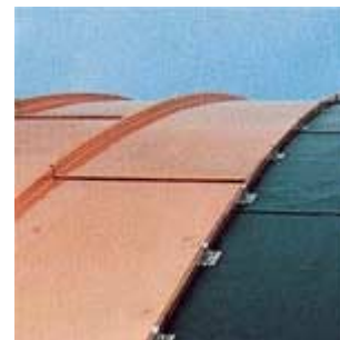
Nastri TECU® Classic connessi con la tecnica della aggraffatura
