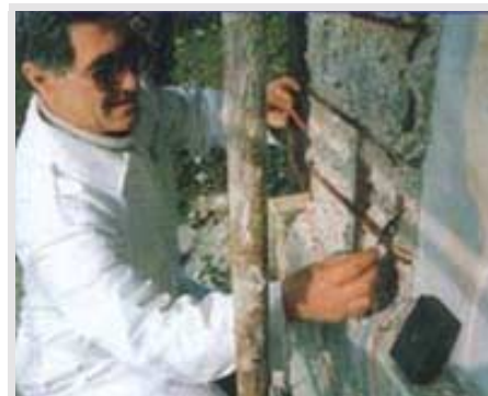
Applicazione del sistema ELKINET C per risanamento del cemento armato
