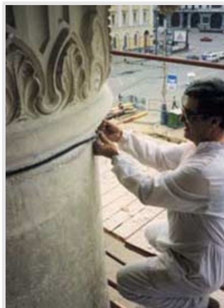
Applicazione linea anodica sulle colonne del Teatro Bolshoj di Mosca
